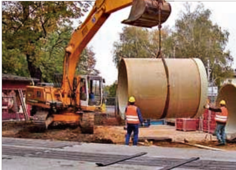
So groß wie diese Rohre für den Stauraumkanal, der 2007 in Torgau, Kreuzung Wolffersdorffstraße/Repitzer Weg verlegt wurde, müssen die Leitungen für die Abwassererschließung der „Kleinen Maßen“ in Weidenhain nicht sein. Mit einem Durchmesser von 2.400 mm entspricht der Torgauer Stauraumkanal allen Anforderungen und kann selbst größere Wassermengen bei Starkregen aufnehmen. Die Arbeiten verrichtete die Firma Joseph Pfaffinger, Leipzig.
