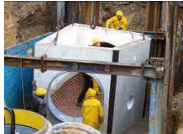
Das Stauraumvolumen des Mischwasserkanalnetzes musste – wie hier am Dr.-Külz-Ufer – durch neue Rohre vergrößert werden.
