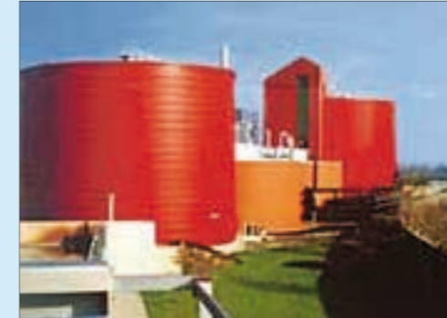
Die hochmoderne Kläranlage in Torgau reinigt und entsorgt die Abwässer aus der Stadt Torgau und den Gemeinden Elsnig, Dreiheide und Zinna.
