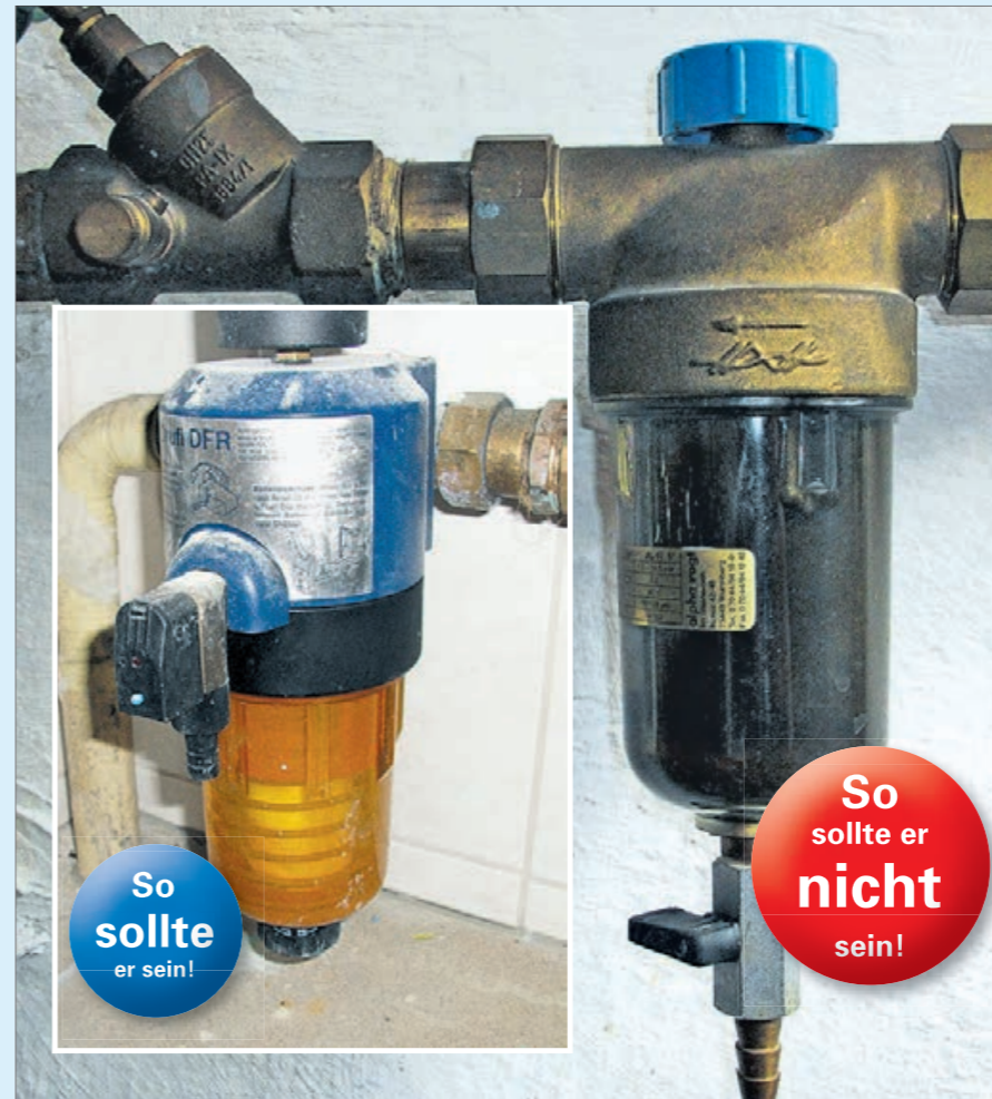
Hell und durchsichtig, wie auf dem linken Foto, sollte der Filtereinsatz aussehen! Rechts ist er dunkel und versifft. Wechselfilter kann man selbst austauschen. Die Einsätze gibt's im Sanitärfachhandel oder beim Klempner. Rückspülbare Filter sind alle zwei Monate zu spülen. Bei Fragen können Sie sich an Herrn Kopski vom Anschlusswesen wenden (Telefonnr. Unten).
