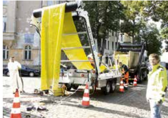
▲ 11. Oktober 2023, Nordring: Teamleiter Benjamin Köhler (re.) vom Ingenieurbüro Fichtner begleitet den Start der Sanierungsarbeiten mit dem Inliner-Verfahren.
