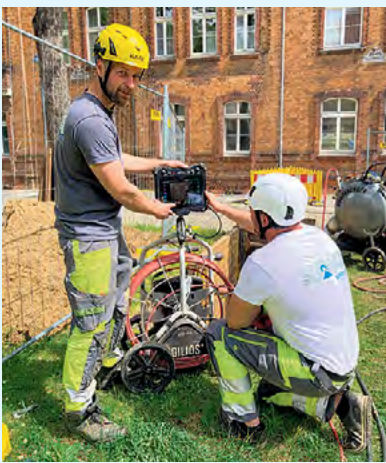
Rohrsanierung geht einfach? Von wegen! Beim Inlinerverfahren kommt viel Technik zum Einsatz. Für diese Sanierungstechnik wird in das Altrrohr ein Fließmaterial eingezogen, auf das ein Kunststoffharz aufgetragen wird. Das grüne Rohr gehört zu einem Anschlusskanal für den Straßeneinlauf und wurde erneuert.
