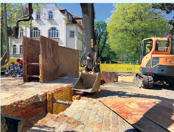
Im Kreuzungsbereich August-Bebel-Straße/Unruhstraße wurde ein neues Schachtbauwerk eingesetzt. Mitte April waren die Bauarbeiten in vollem Gange, Anfang Mai war die Straßendecke schon wieder geschlossen.
