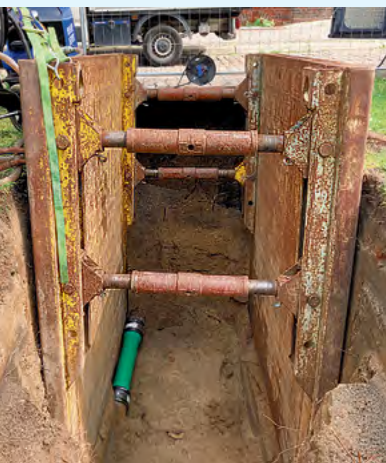
Rohrsanierung geht einfach? Von wegen! Beim Inlinerverfahren kommt viel Technik zum Einsatz. Für diese Sanierungstechnik wird in das Altrrohr ein Fließmaterial eingezogen, auf das ein Kunststoffharz aufgetragen wird. Das grüne Rohr gehört zu einem Anschlusskanal für den Straßeneinlauf und wurde erneuert.
