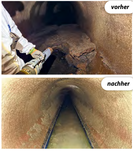
Die Ablagerungen werden mit Wasser per Hochdruckspülverfahren gelockert und anschließend abgesaugt. Nun sind die Rohre wieder frei für den Durchfluss von großen Abwassermengen.
